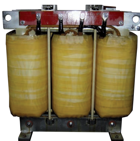
Autotrasformatori trifase per avviamento motori
